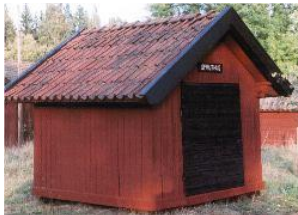
Spruthuset i Åbyggeby
