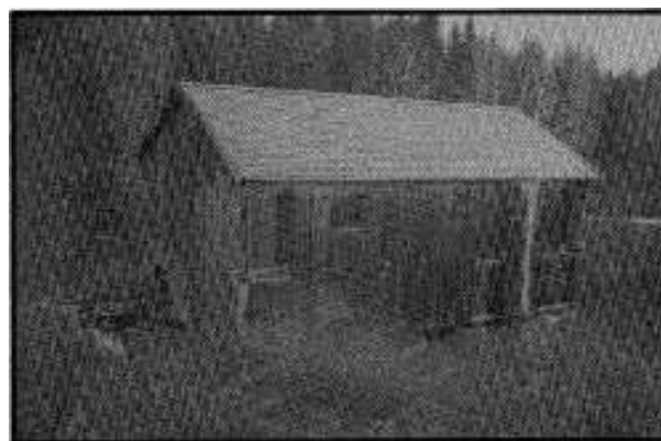
Linskäkten innan den reparerades. Foto: Bror Olsson
